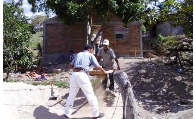
Armutsorientiertes Bauen fördert die Selbsthilfe.
