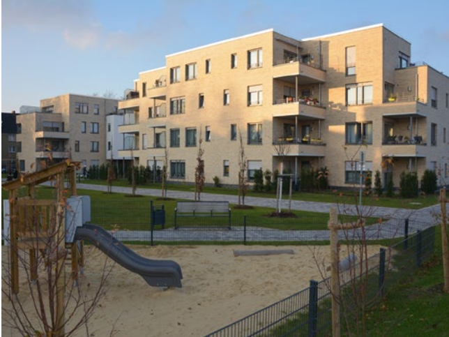
48 Mietwohnungen Lünen, Otto-Klug-Weg 4, 6, 8, 10, 12 Fertigstellung 2. Quartal 2017
