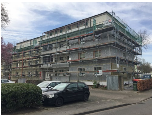
Energetische Maßnahmen WDVS Lünen, Veilchenweg 23 a, b, c, d
