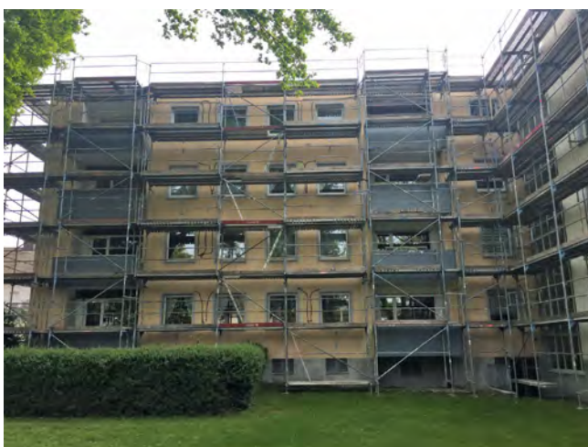
Energetische Maßnahmen WDVS Lünen, Von-Born-Straße 34, 36, 38
