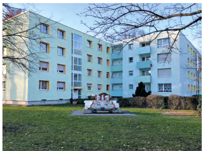
Energetische Maßnahmen WDVS Lünen, Von-Born-Straße 34, 36, 38
