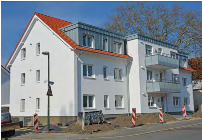
Mehrfamilienhaus Lünen-Horstmar, Querstraße
